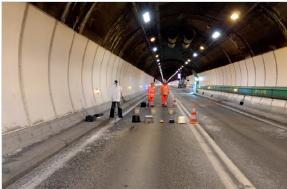
In het najaar van 2018 werden samen met het Franse CETU al proeven gedaan in de Mont Blanc tunnel. (Foto: werkgroep COB/Harry de Haan)
