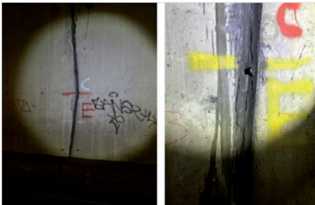
Tijdens een nachtelijke inspectie in de Willemspoortunnel werd gekeken naar de mootvoegen (visbekvoegen). (Foto: COB)
